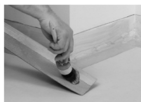
Aplique cola en el suelo y la pared hasta alcanzar la línea.
