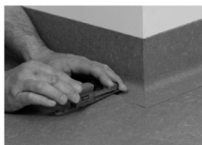
Corte el pavimento para suelo que quede por encima del rodapié.
